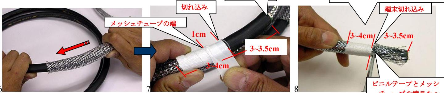
6.7.ケーブルにメッシュチューブを被せ、まず、ケーブルの片側の端末の切れ込みから1cmのところにメッシュチューブの端を合わせ、幅3~4cmにわたりビニルテープをきつく巻き付ける。
