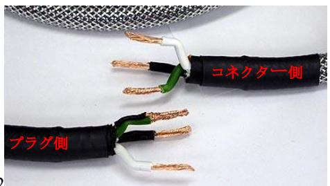
30. プラグ側のホット線・コールド線・アース線の絶縁体の中央付近をラジオペンチで掴み、先端方向に曲げる。
