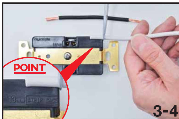
3-4：白と黒の渡り線にも同様に、13mmのところに切れ込みを入れ、絶縁材を剥きましょう。
