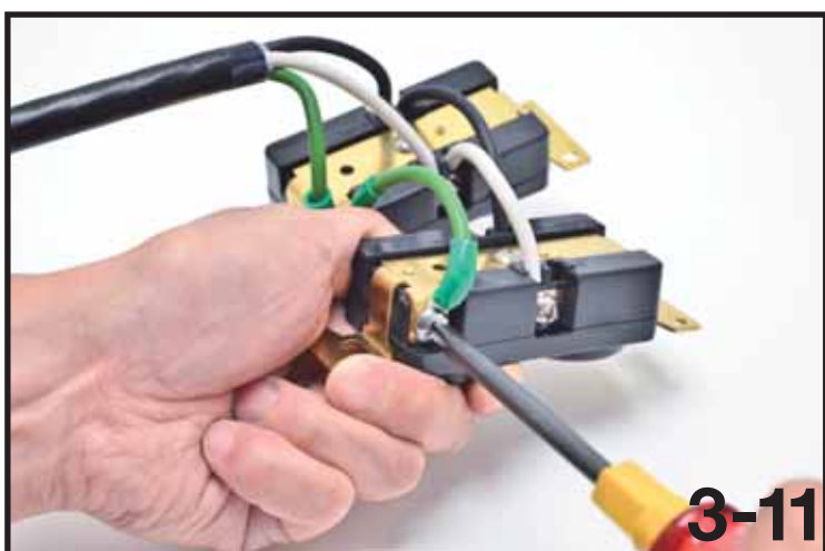
3-11：アース渡り線を2個目のコンセントのアースに挿し込み、ネジ止め固定します。
