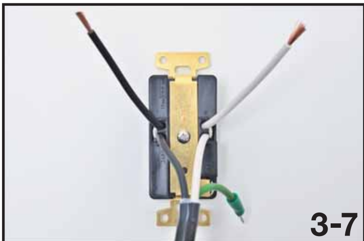
3-7：次にケーブルのコールド線(白)をコールド側に、ホット線(黒)をホット側に挿し込みます。
