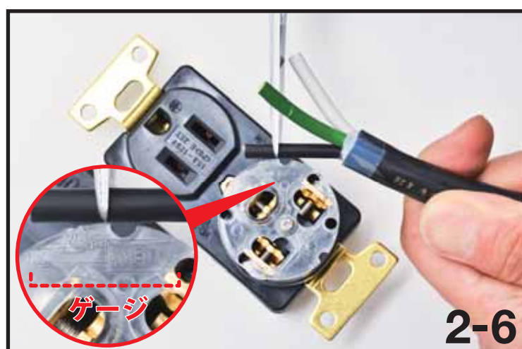
2-4：プラグ本体をコンセントに挿しプラグ裏面のゲージを目安に芯線端末から10mmの箇所にハサミで切れ込みを入れます。
