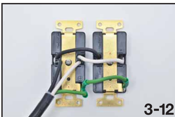
3-12：渡り線を配線し終えた状態です。間違いがないか再度確認しましょう。
