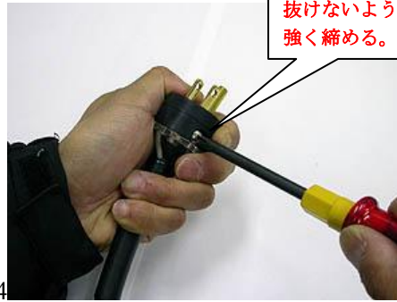
13 プラグ本体のケーブル差込口にケーブル導体を差し込み、プラグ本体ネジを締めて導体を固定する。
